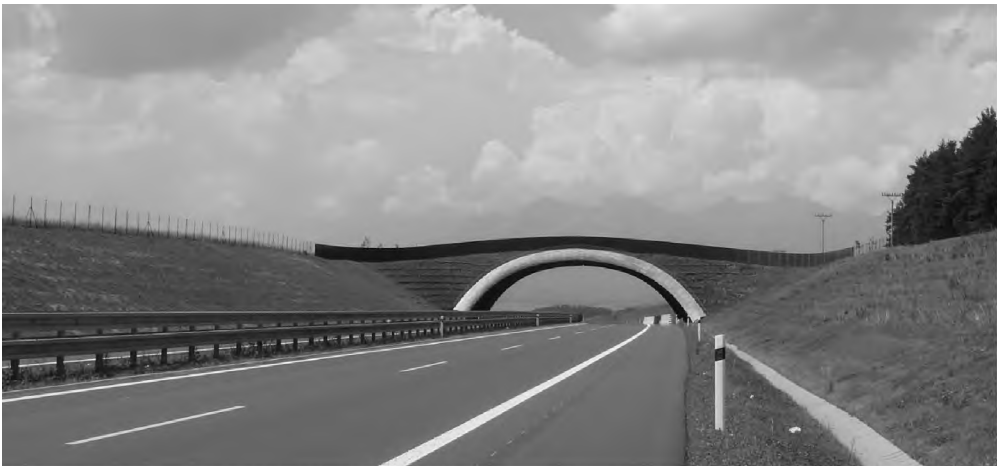
Obr. 5.1 Ekodukt na diaľnici D1, úsek Mengusovce – Jánovce
